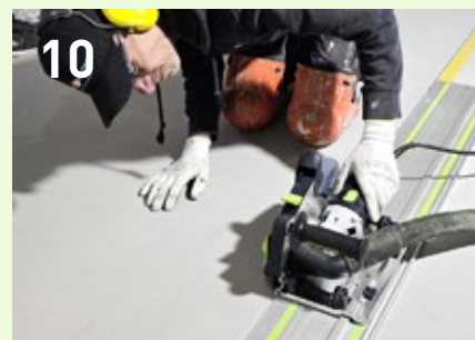
A DSC AG 125 és a vezetősín segítségével vágja fel a feltöltődött tágulási hézagokat. Tipp: hosszabb tágulási hézagok esetén több vezetősín is összekapcsolható.
