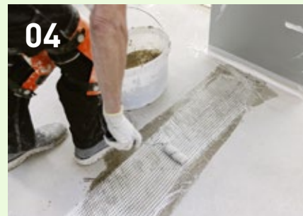
Helyezzen hullámos kötőlemezeket a vágásokba, majd gyantával zárja le azokat. Ezután helyezzen fel üvegszálás szövetet és csiszolja meg kvarchomokkal.
