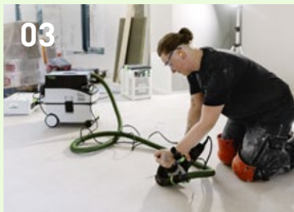
Vágja fel a repedéseket vagy a betörmökött tágulási hézagokat a DSC AG 125 FH kézi vágórendszerrel.
