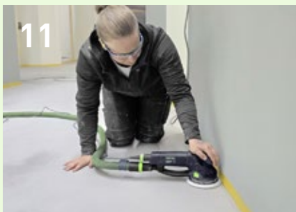
A teljes padlófelület csiszolása: nagy felületeken Trio tányéros csiszológéppel, a széleken és nehezen elérhető helyeken RÖTEX RO 150 vagy RO 90 géppel.
