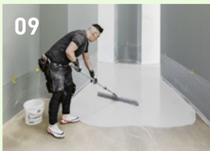
Öntse a padlóburkoló masszát az aljzatra, majd egy simítóval egyenletesen oszlassa el. A Pandomo Floor Plus esetében kemény szemcsés homokot kevernek a padlómasszába.
