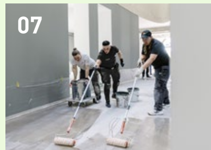
Az optimális tapadás elérése érdekében az egész padlózatot alapozza (a példában Pandomo EP-vel), majd kvarchomokkal csiszolja.
