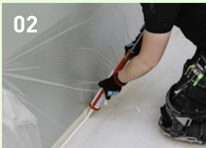
A szegélyszigetelő szalag és a padló közötti hézagokat akril tömítőanyaggal tömítse.
